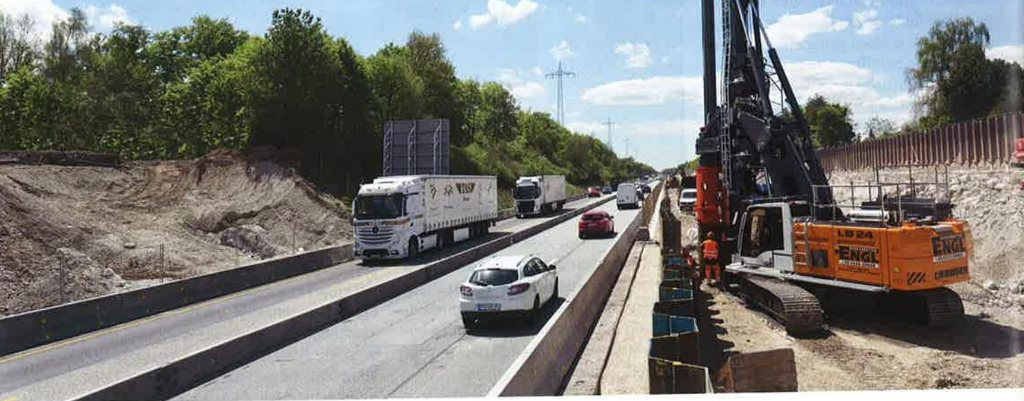
Für Gründungsarbeiten im Rahmen der Spurerweiterung der süddeutschen Autobahn A 96 setzt die Telekrane Engl GmbH ein Liebherr-Drehbohrgerät vom Typ LB 24-270 ein. Die mit einem Bohrantrieb der BAT-Serie ausgerüstete Maschine arbeitet am neuen Galeriebau bei Germering. Die etwa 900 m lange Galerie wird im Zuge der Erweiterung der Lindauer Autobahn errichtet, um die Bewohner der Großen Kreisstadt besser vor Verkehrslärm zu schützen.
